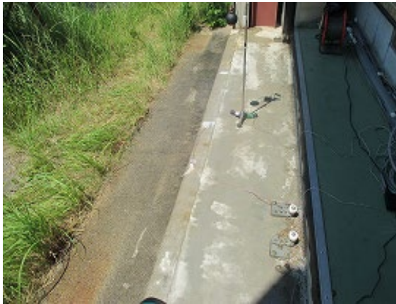
写真6：打ち水箇所の可視画像（打ち水10直後）
